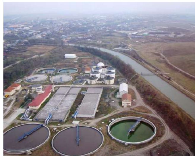
Fig. 4.47. Stația de epurare apă uzată Piatra Neamț (Sursă: https://zch.ro/ )
